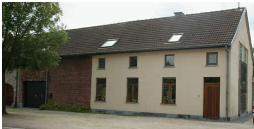
Le plâtrage décoratif de la façade avant indique clairement quelle partie de la maison a été rénovée en 2001. Une rénovation similaire est prévue pour la partie gauche.
