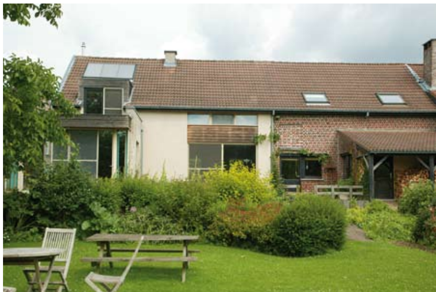
Les panneaux solaires pour le chauffe-eau ont une superficie de 4 m 2 .
